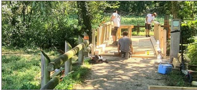
L'entreprise "Pyramide rénovation" était en charge des travaux qui sont désormais terminés. Photo Progrès/Florian SALCE
